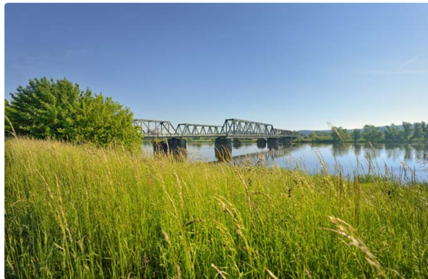
Nieczynny most na Odrze w okolicy Bienerwerder Geschlossene Oderbrücke in der Umgebung von Bienerwerder Unused bridge over the Oder near Bienerwerder
