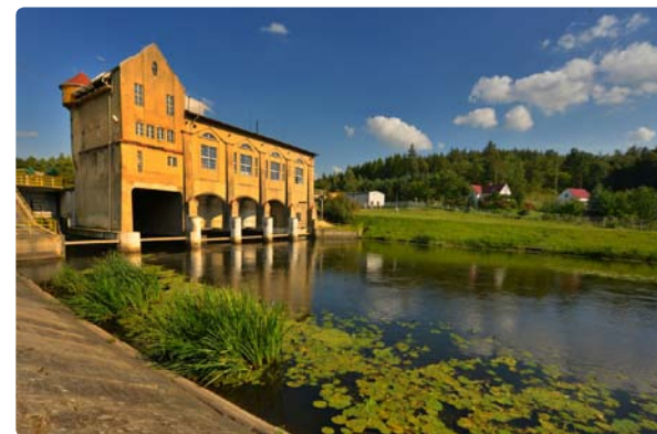
Elektrownia wodna na Odrze w Bledzewie Wasserkraftwerk auf der Oder in Bledzew Hydroelectricity plant on the Oder in Bledzew
